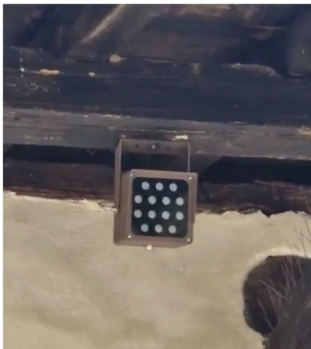
Vista cortile d'ingresso Dettaglio con prova installazione corpo illuminante
