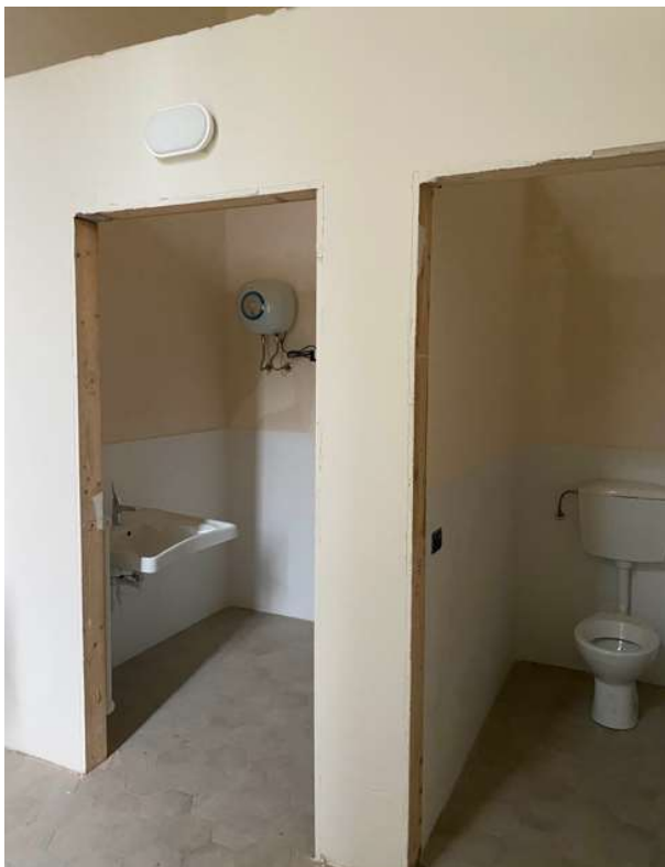
Foto 11- servizi igienici da ultimare
