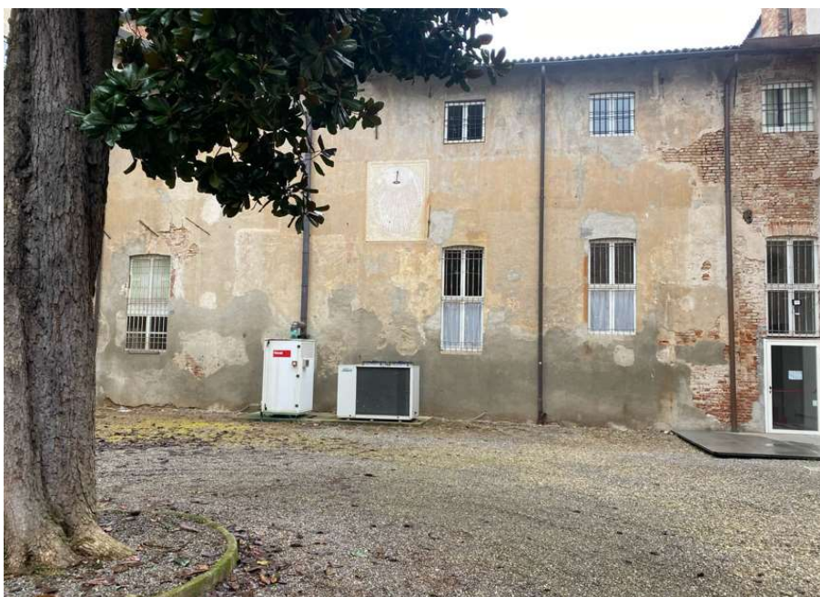
Foto 13 – corte della meridiana vista impianti da schermare
