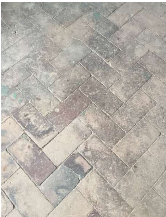
Foto 8 – pavimento in cotto da restaurare
