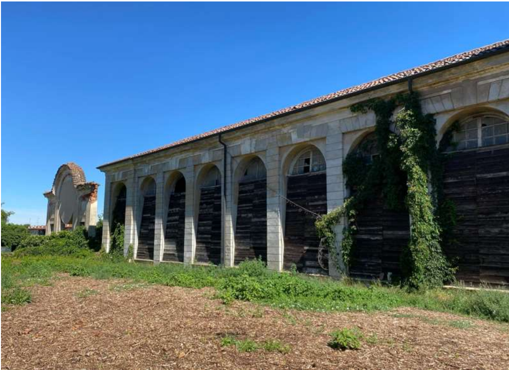
Prospetto manica delle serre e portale con meridiana sullo sfondo
