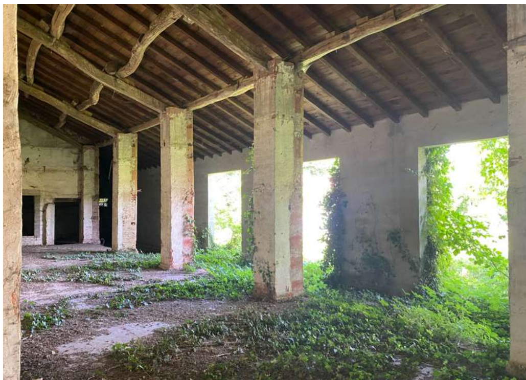
Vista interna volume rustici sulla corte 1 addossati alla manica delle serre
