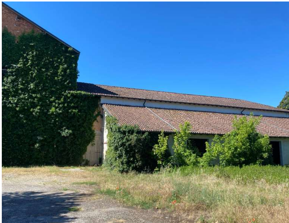
Volume rustici sulla corte 1 addossati alla manica delle serre
