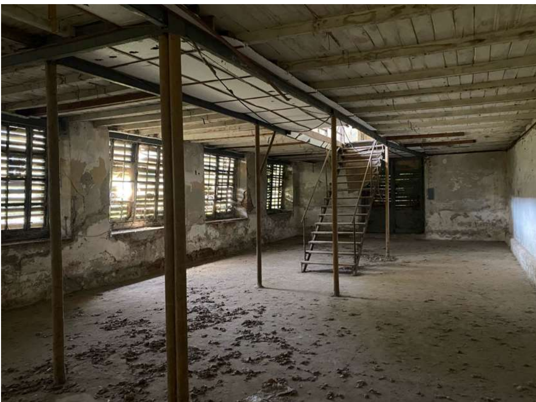
Vista interno piano terra serre con struttura solaio intermedio
