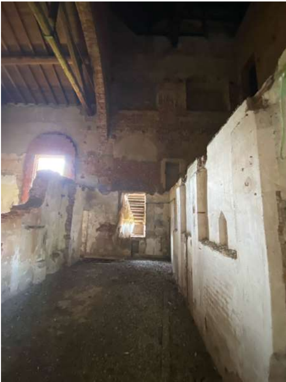
Vista interna volume di servizio al lato dx dell'ingresso
