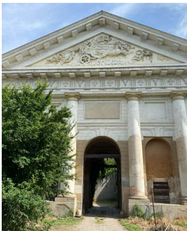
Corpo centrale ingresso monumentale
