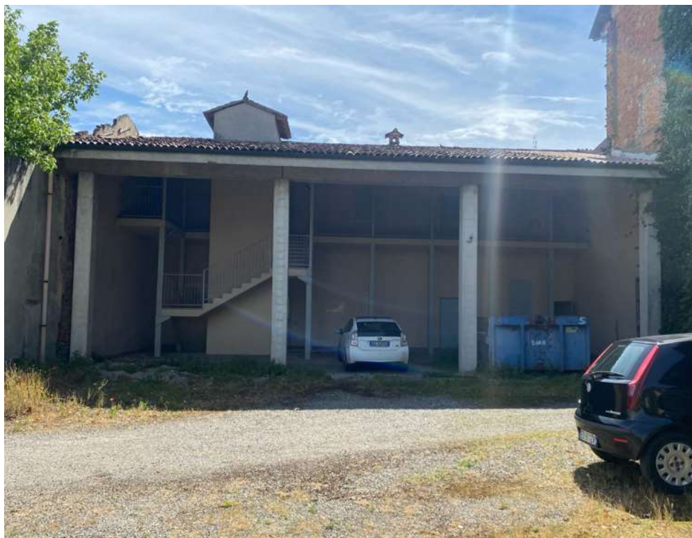
Vista portico sulla corte 1 distribuzione unità abitative
