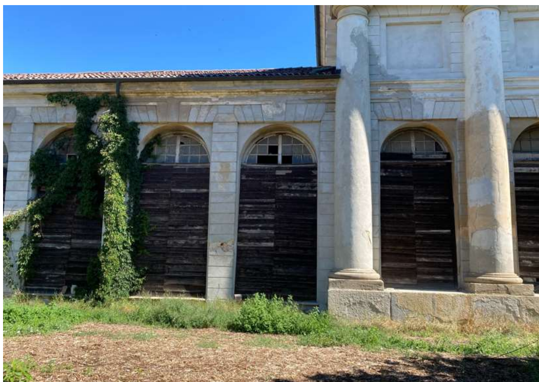
Particolare prospetto volume serre con serramenti tamponati con assi di legno
